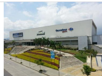
Ampliación Centro Comercial Limonar en Cali (Colombia) con la incorporación de 2.371 m 2 adicionales de GLA.
