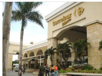
Ampliación centro comercial Altos del Prado en Barranquilla (Colombia), con la incorporación de 1.517 m 2 adicionales de GLA.
